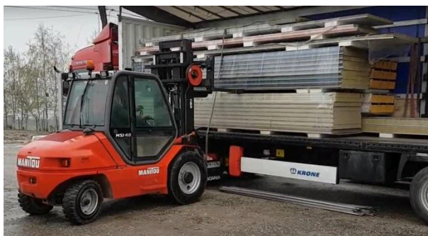
(ukážka vykladania panelov vysokozdvížným vozíkom)
